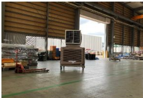
工場の出入り口に設置し外気を取り込む
