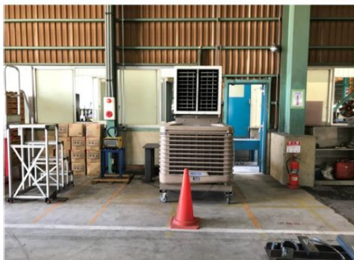
工場の出入り口と隣の棟の通路口に設置により外気を取り込む
